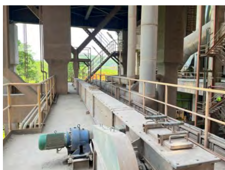
รูปที่ 2-28 ระบบสายพานแบบปิดเพื่อลำเลียงฝุ่นจาก P/H Boiler กลับเข้าสู่กระบวนการผลิต
