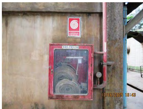
รูปที่ 2-45 ระบบสัญญาณเตือนภัย สัญญาณเตือนไฟไหม้ และอุปกรณ์ดับเพลิง บริเวณพื้นที่โรงงาน 3 (สายการผลิตที่ 5 และ 6)
