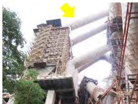
รูปที่ 2-27 ท่อนำความร้อนทิ้งจาก P/H Boiler และ Clinker Cooler โรงงาน 3 (สายการผลิตที่ 5 และ 6)
