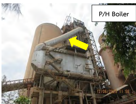
รูปที่ 2-3 ท่อนำความร้อนทั้งจาก P/H Boiler และ Clinker Cooler โรงงาน 2 (สายการผลิตที่ 3)
