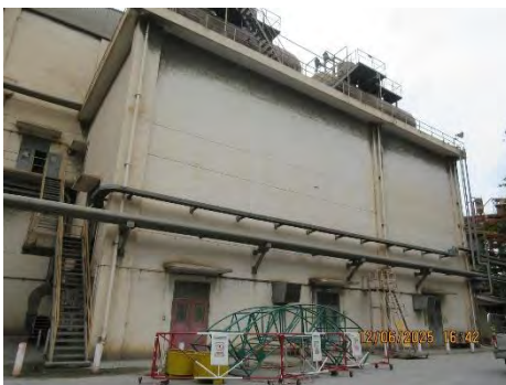
รูปที่ 2-32 อาคารปิดคลุมเครื่องจักรที่มีเสียงดังภายในพื้นที่โรงงาน 3 (สายการผลิตที่ 5 และ 6)
