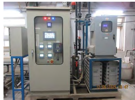
รูปที่ 2-39 ระบบ EDI (Electrodeionization)
