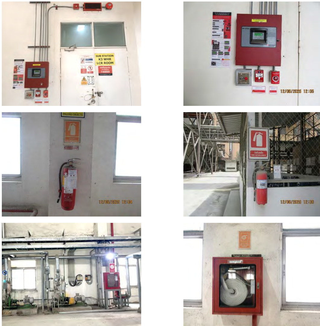
รูปที่ 2-22 ระบบสัญญาณเตือนภัย สัญญาณเตือนไฟไหม้ อุปกรณ์ดับเพลิง บริเวณพื้นที่โรงงาน 2 (สายการผลิตที่ 3)
