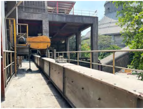
รูปที่ 2-29 ระบบสายพานแบบปิดลำเลียงฝุ่นจาก Dust Precipitation กลับเข้าสู่กระบวนการผลิต
